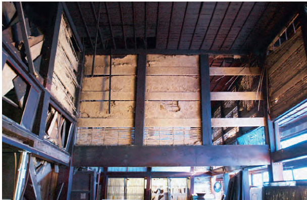
震度7にも耐えた、木組み構造を補完する通し貫（3本の白い横材）
