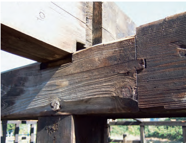
仕口、継手に技が光る、世紀を超えて風雪に耐えた木組みの構造
