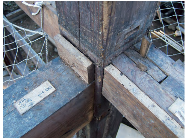
築130年。大震災をも耐え抜いた大黒柱に取りつく横架材の接合部
