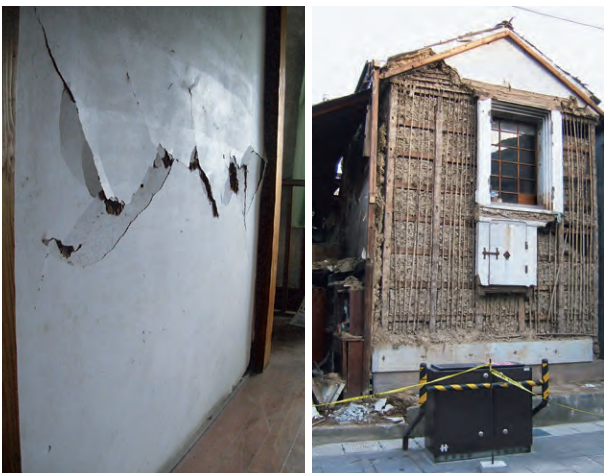
土壁は地震時には、フレーム（骨組み）を守るバンパーの役割を果たす
