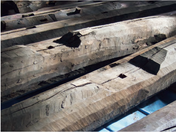
再生のために外された梁材にみる、手斧で削られた木肌の美しさ
