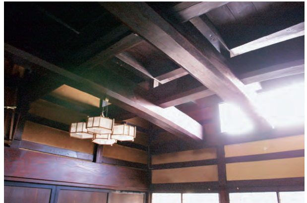
水平平面の靱性を守る力強い木組みの梁が、緩やかな曲線美を見せる伝統民家
