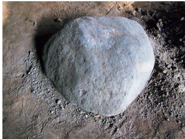
ひかりつけされた柱と礎石に、先人による免震の知恵をみる
