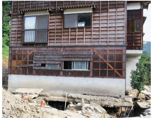
既存建物であっても、地盤・基礎から手を入れることはできる
