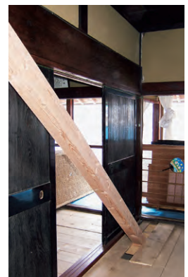
倒壊防止の応急処置
