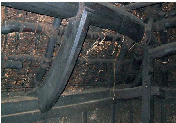
木の癖を読み、刻まれ、巧みに組上げられた、かやぶき民家の構造
